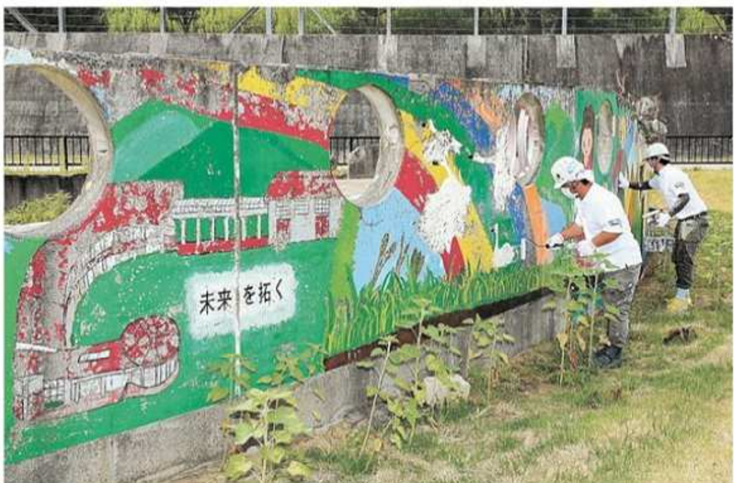
壁面に塗料を塗る作業員
