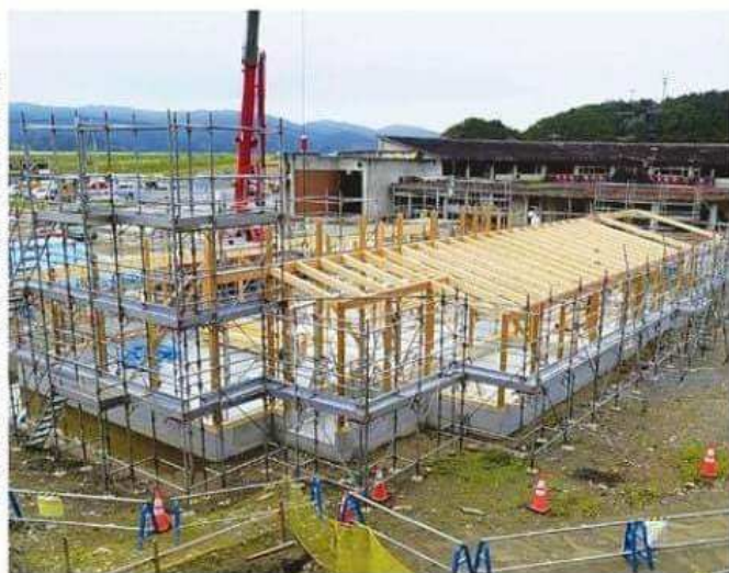
震災遺構として整備が進む、大川小の敷地に建設中の管理棟（手前）＝いずれも石巻市で
