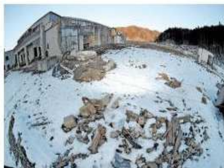
震災前まで津波避難所に指定されていた大川小の体育館。コンクリート部分だけが残る
