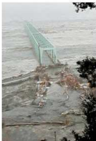
新北上大橋周辺に襲来した津波＝2011年3月11日午後3時42分ごろ、石巻市（市提供動画の一場面）
