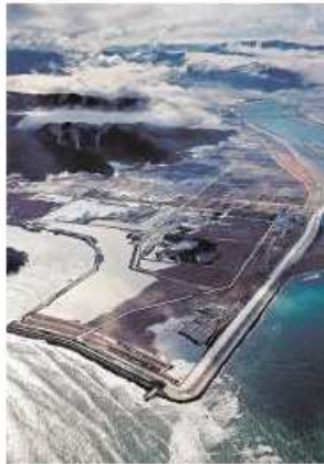
護岸工事が進む現在の松原周辺(手前)。数万本の松林は、美しい砂浜とともに跡形もなく消えた
