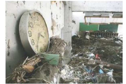
津波で壊れた大川小の掛け時計。午後3時37分で止まっている＝2011年3月29日
