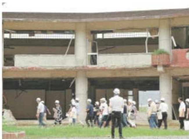
大川小の被災校舎を視察する検討会議のメンバー
